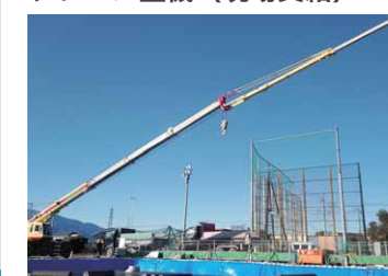
クレーン重機（現場支給）
