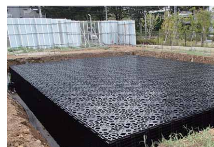
6 ユニット組立／完了・出来高確認
