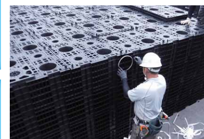
7 流入(流出)口／管口加工 (現場支給)
