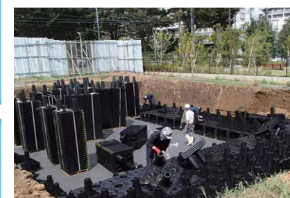
4 ユニット組立／本体ユニット組上げ
