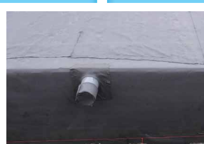
8 流入口／管口取付け状況
