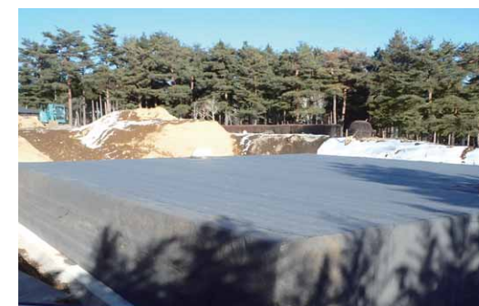
▲ ゴルフ場／芝散水用貯水槽
