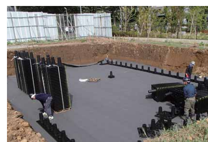
3 ユニット組立／底部ユニット敷設
