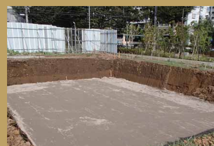
1 掘削／基礎工事
