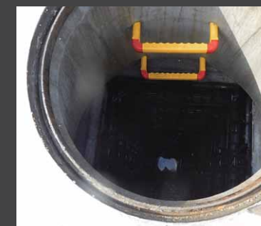
▲ ハイドロスタッフ上部の点検人孔部
