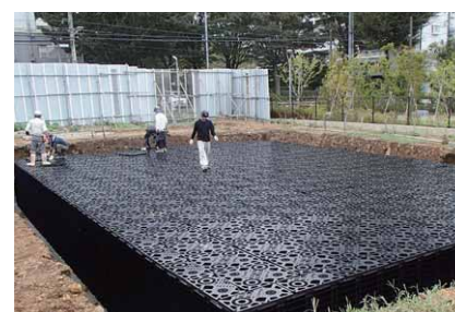
5 ユニット組立／天板敷設
